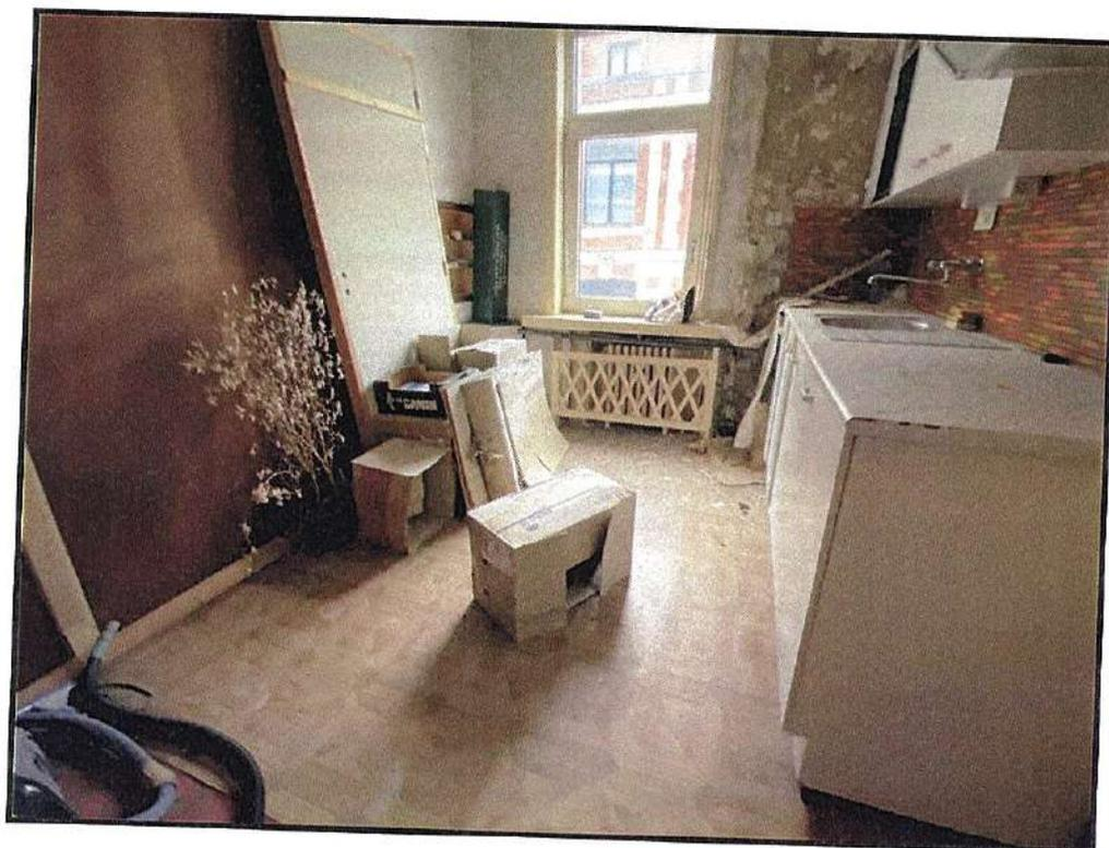
Présence, au niveau du mur pignon, d'un important dégât des eaux sur la droite du châssis de fenêtre.
