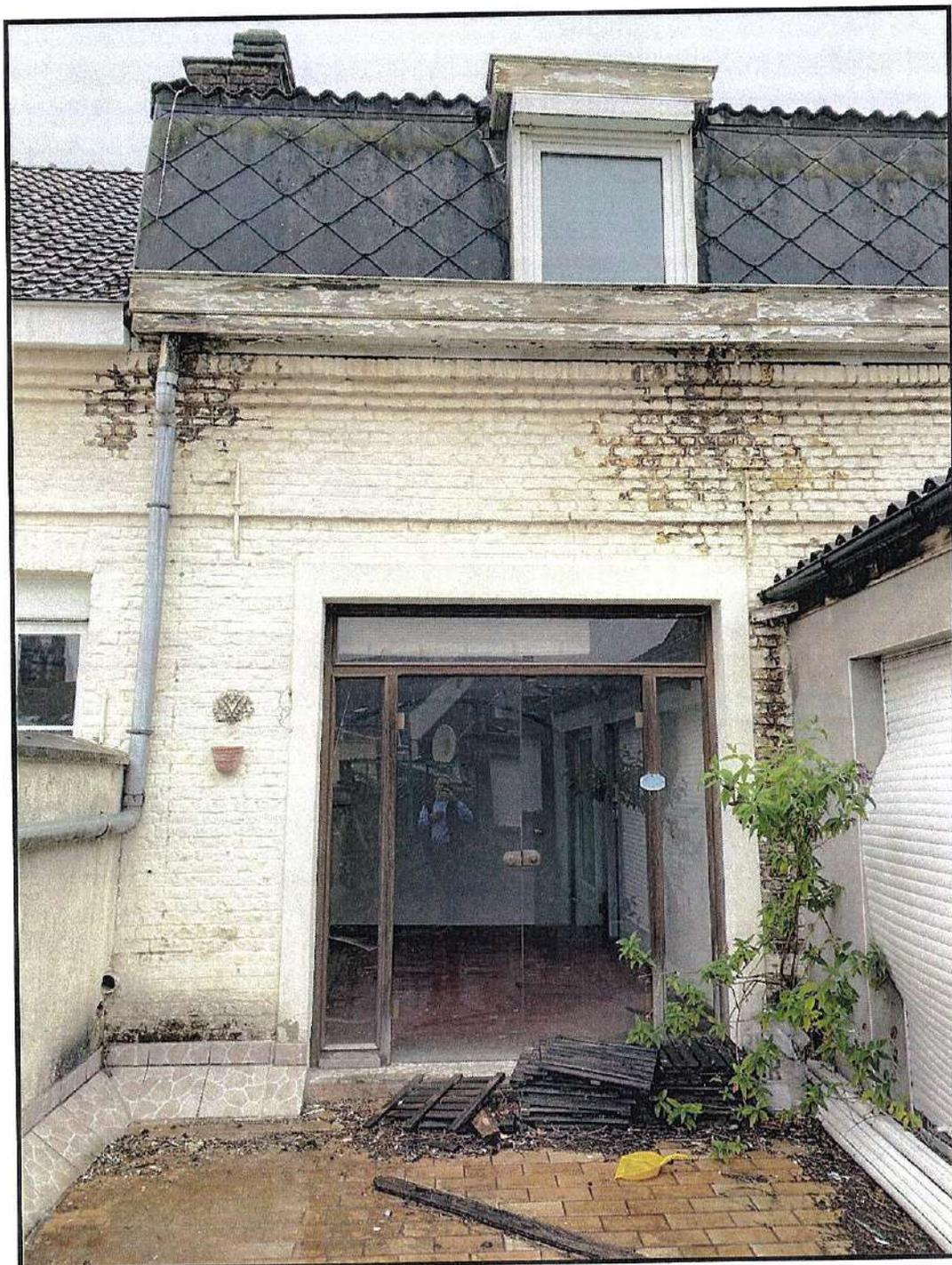
Les chéneaux en bois sont en mauvais état, marqués également par des infiltrations.
