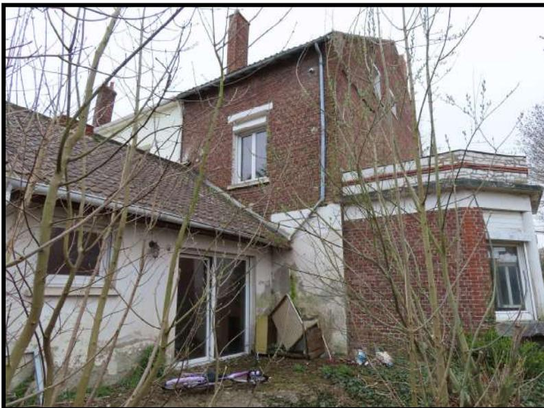
En pignon, présence d'une excroissance en maçonnerie de briques à toiture plate.
