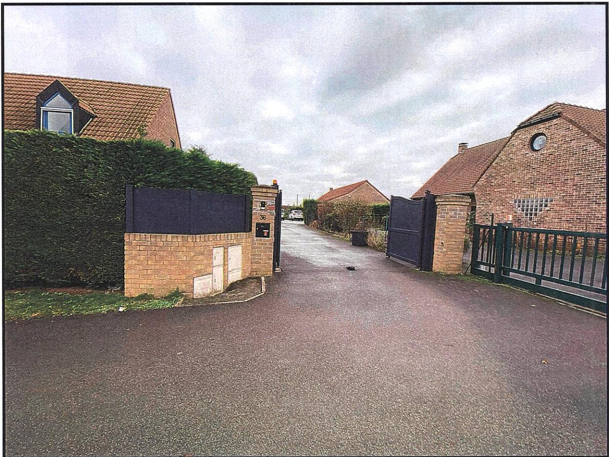
De part et d'autres, des pilastres maçonnés élevés sur briques et soubassement recevant les différents compteurs (gaz et EDF).
