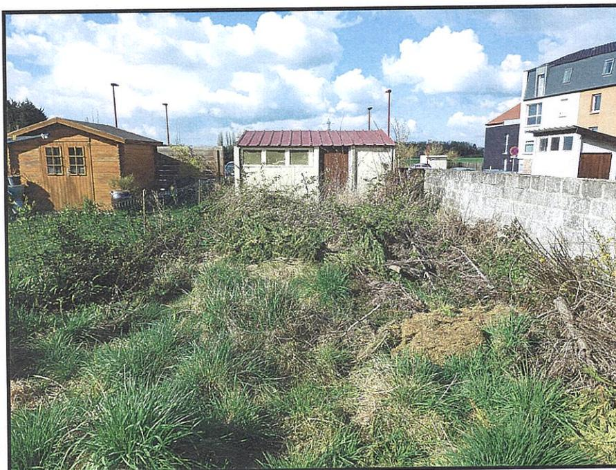
Il existe un cabanon dans ce jardin avec porte en bois ancienne, sol chape béton fissurée, murs constitués de panneaux béton avec toiture en tôles métalliques.
