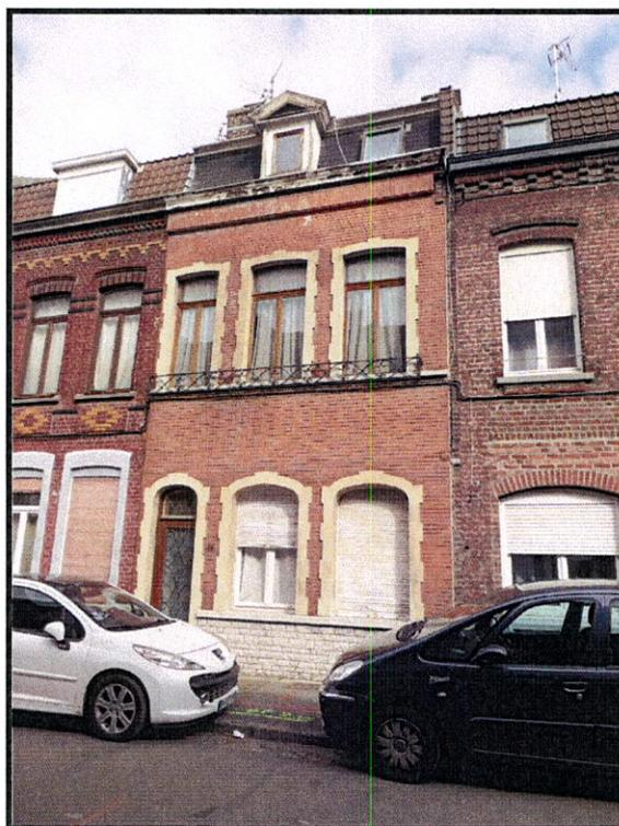
Il s'agit d'un immeuble d'habitation de type large 1930 sur rue avec double mitoyenneté, dressé en maçonnerie de briques et couverture tuiles.
