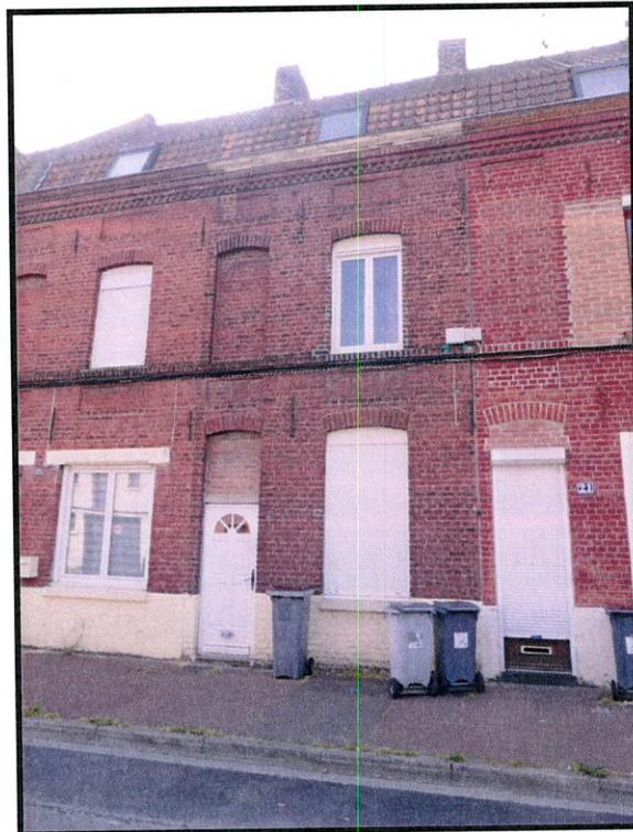
Il s'agit d'un immeuble d'habitation de type 1930 en double mitoyenneté, dressé sur rue en maçonnerie de briques avec couverture tuiles, situé dans une rue en impasse.
