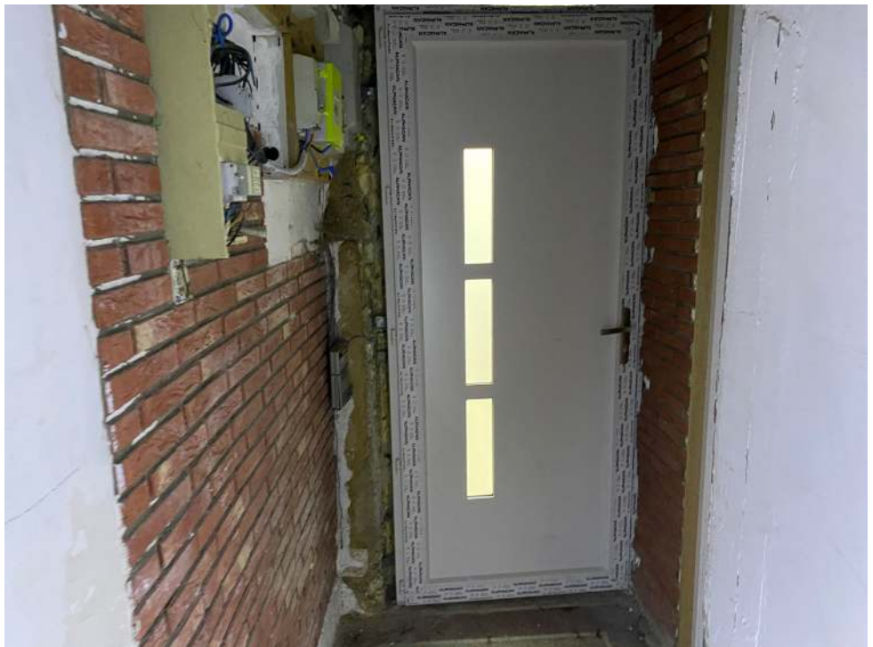
Photographie n°19. Porte d'accès rdc immeuble
