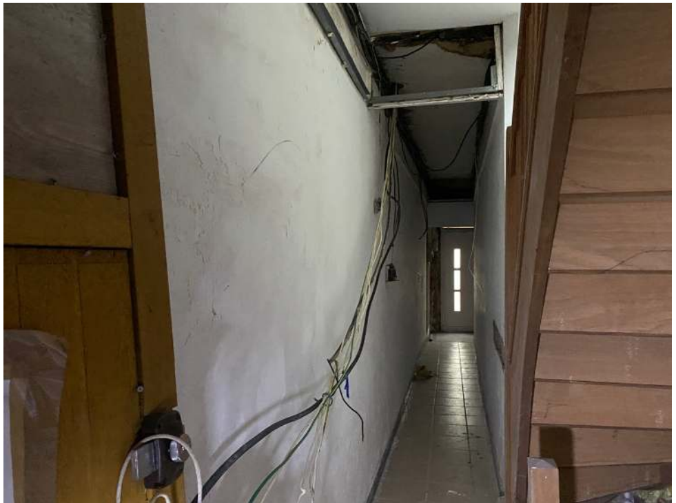
Photographie n°18. Parties communes RDC
