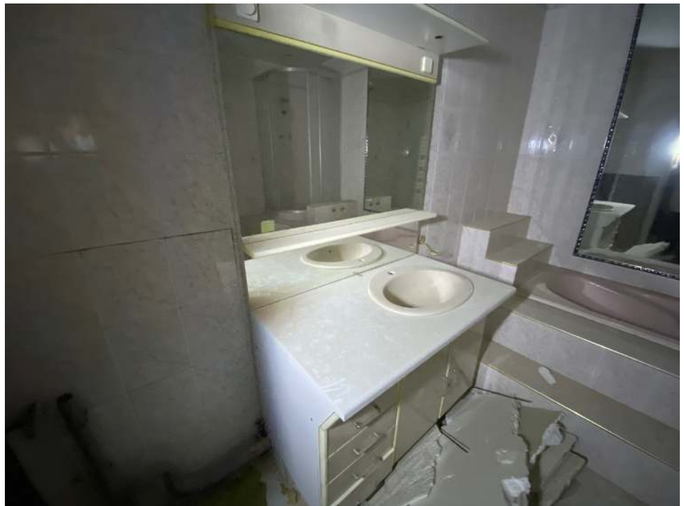
Photographie n°11. Salle de bains lot n°2
