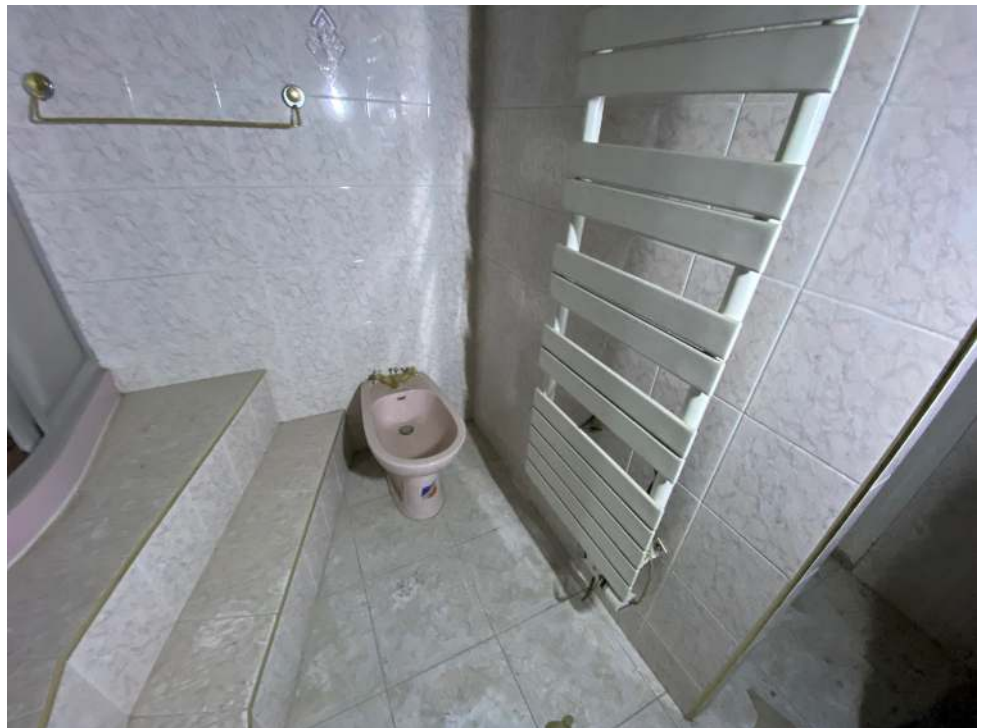
Photographie n°15. Salle de bains lot n°2
