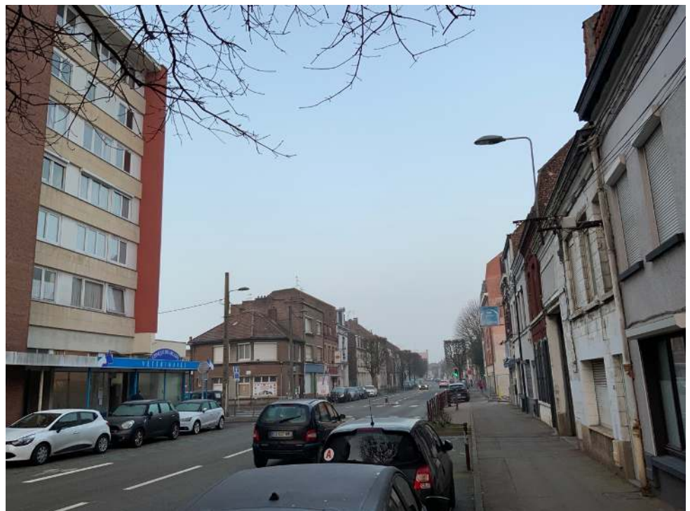
Photographie n°3. Rue face à l'immeuble
