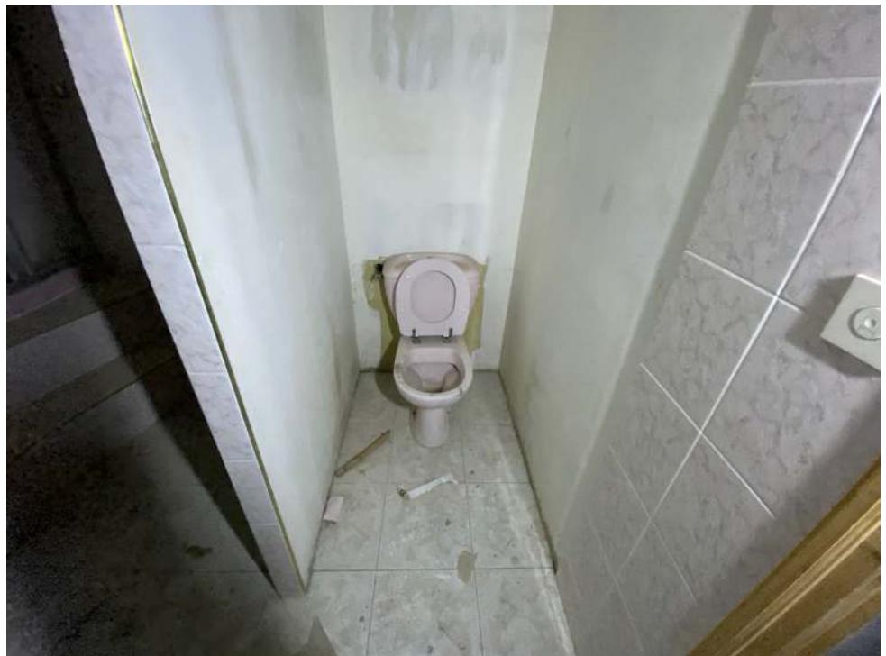
Photographie n°13. Salle de bains lot n°2
