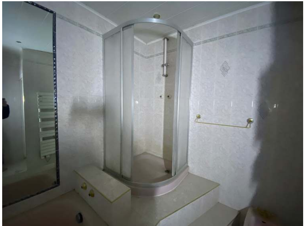
Photographie n°14. Salle de bains lot n°2
