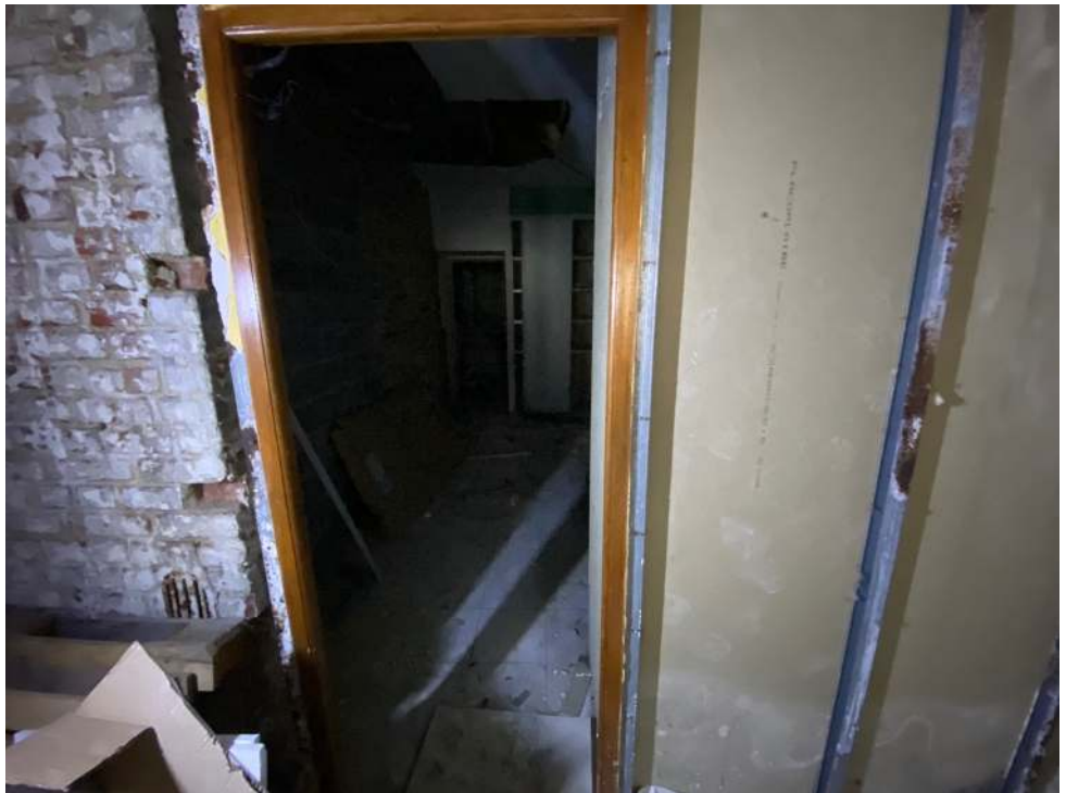
Photographie n°6. Accès chambre lot n°2
