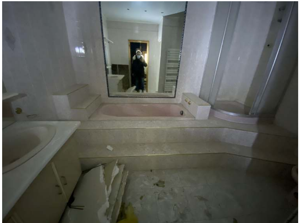
Photographie n°12. Salle de bains lot n°2
