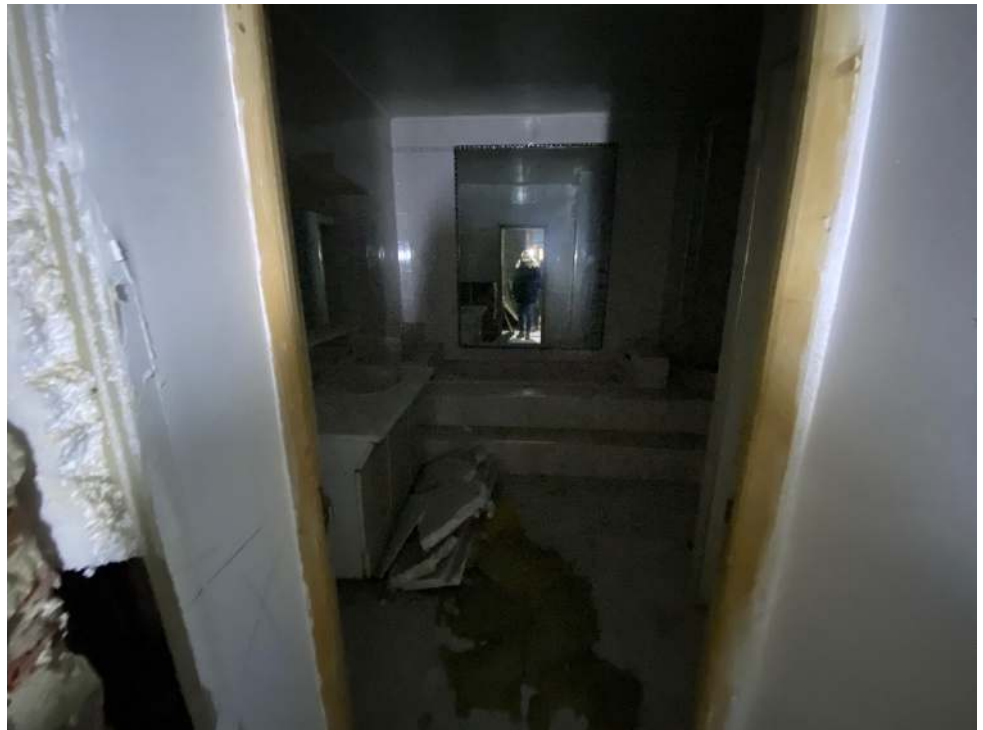
Photographie n°10. Accès salle de bains lot n°2
