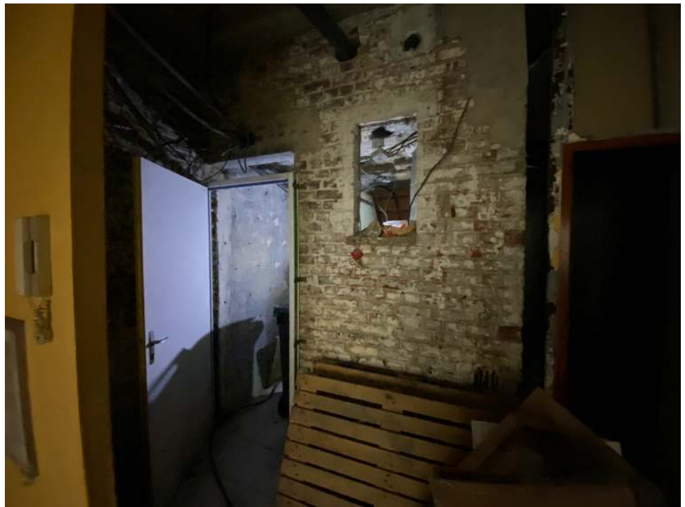
Photographie n°5. Entrée lot n°2
